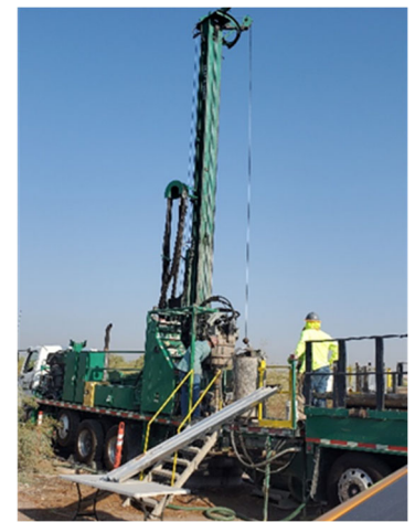
Perforación para la instalación del Pozo de Monitoreo
