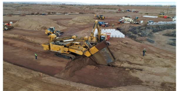
Instalación de Hierro Cero Valente para un estudio de tratabilidad de
